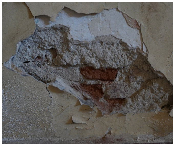
Degradări la nivelul tencuielilor interioare
