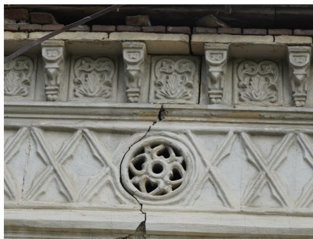
Fisuri ce traversează toate straturile componente ale fațadelor
