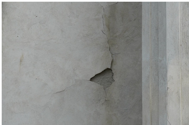
Fațade, desprinderi între straturile de tencuială
