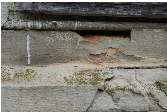
Soclu, desprinderi între straturile de tencuială
