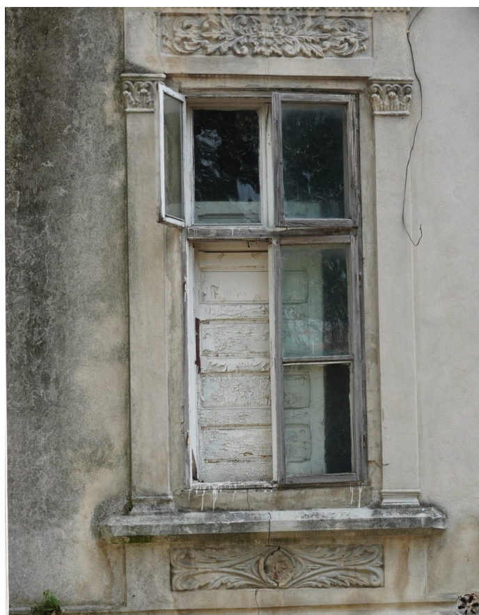
Colorări/pătări ale tencuielilor exterioare produse de acțiunea diferitelor tipuri de umiditate
