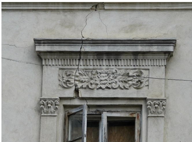
Fisuri ce traversează toate straturile componente ale fațadelor
