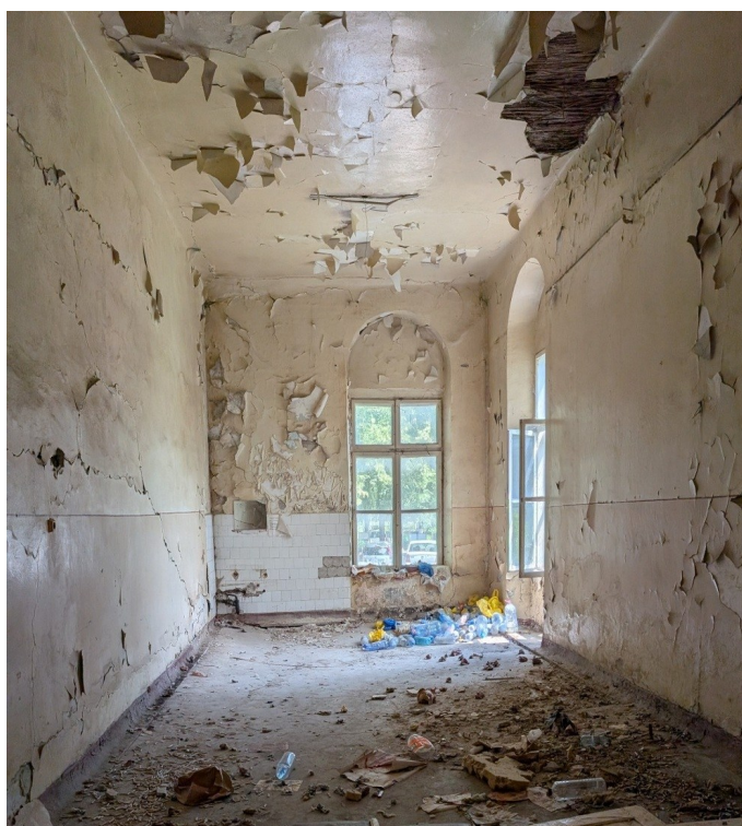
Degradări la nivelul structurii plafoanelor
