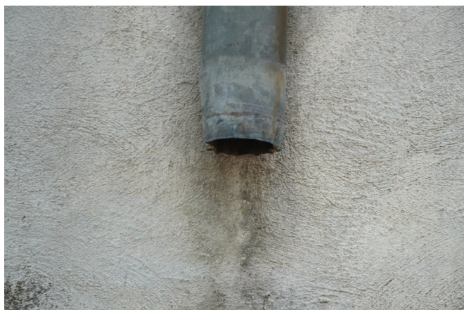
Modificări de tonalitate ale tencuielilor produse de infiltrații
