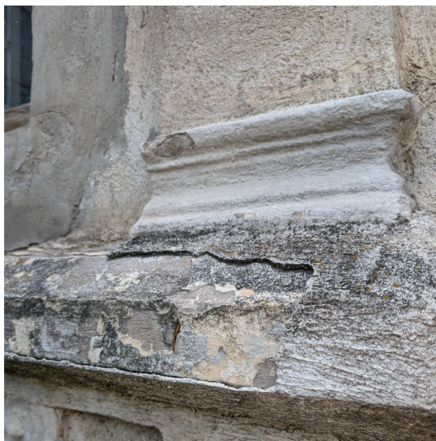
Intervenții cu mortare necorespunzătoare
