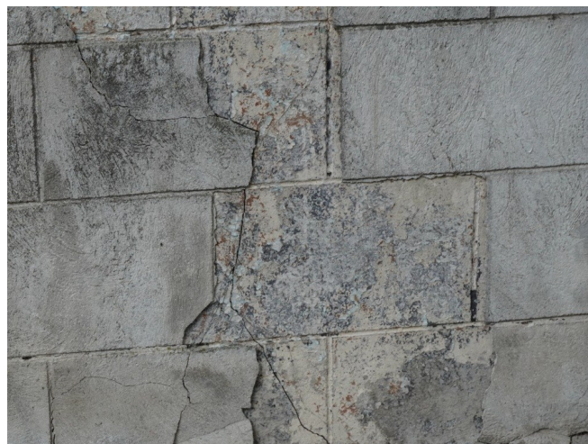
Fisuri ce traversează toate straturile componente ale fațadelor
