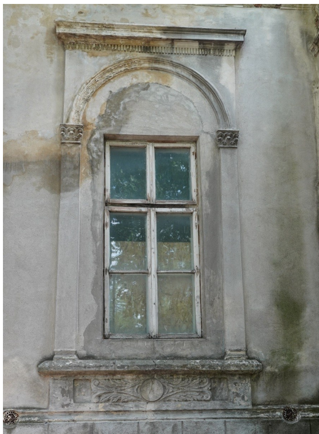
Colorări/pătări ale tencuielilor exterioare produse de acțiunea diferitelor tipuri de umiditate
