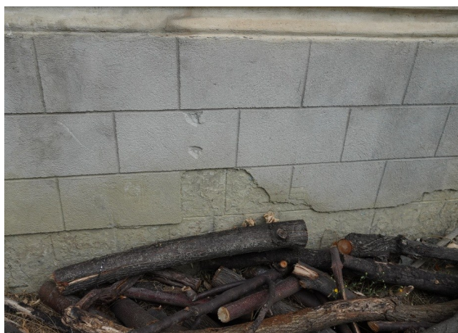
Intervenții cu mortare necorespunzătoare
