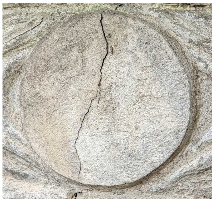
Intervenții cu mortare necorespunzătoare
