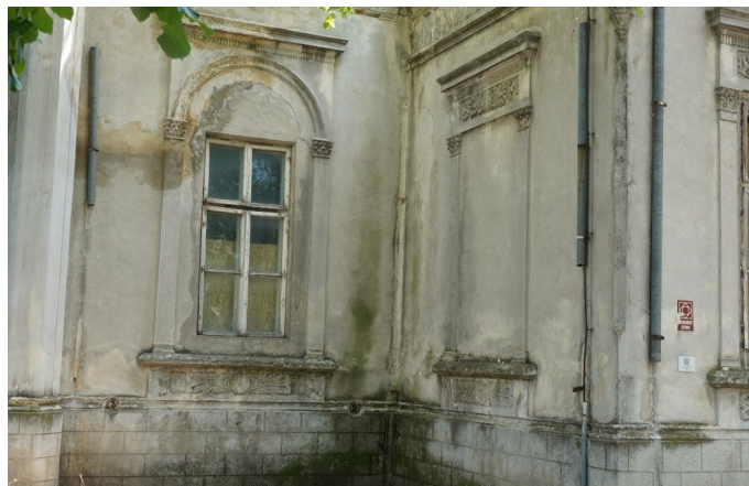
Modificări de tonalitate ale tencuielilor produse de infiltrații
