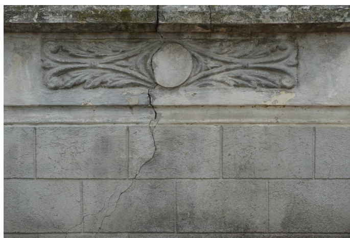
Intervenții cu mortare necorespunzătoare
