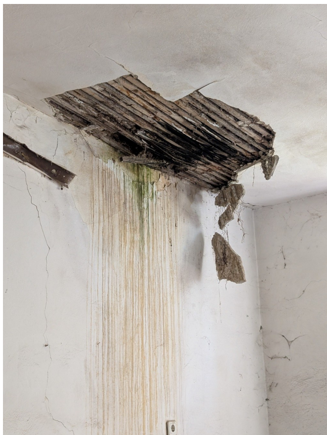
Degradări structurale la nivelul plafoanelor și pereților
