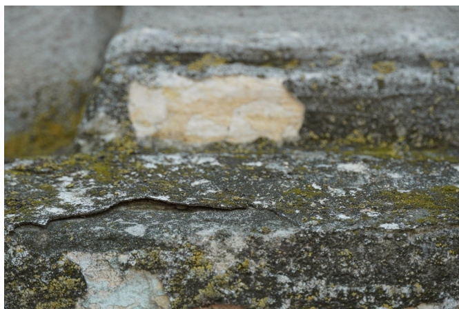
Soclu, desprinderi între straturile de tencuială
