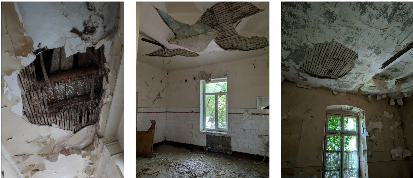
Degradări datorate umidității
