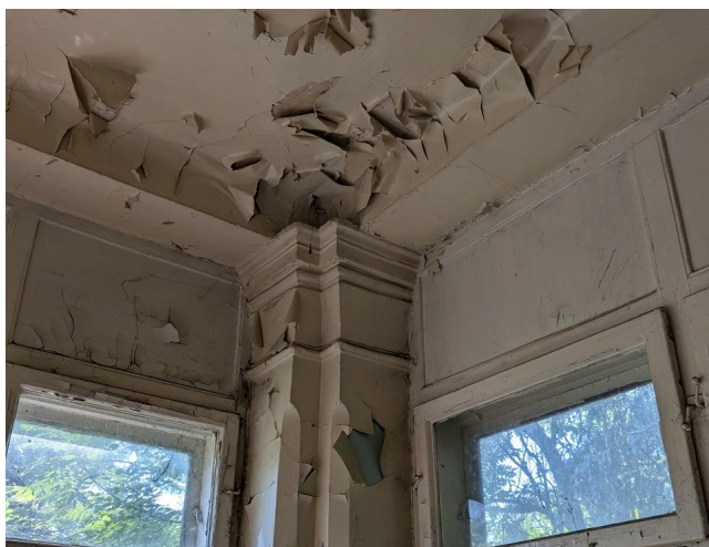
Degradări la nivelul finisajelor interioare
