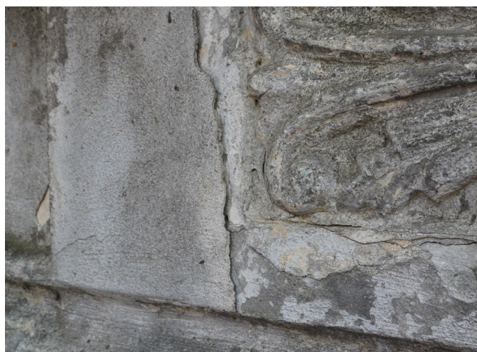
Fisuri ce traversează toate straturile componente ale fațadelor
