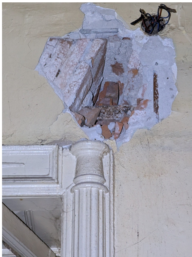
Degradări structurale la nivelul plafoanelor și pereților
