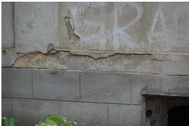
Fațade, desprinderi între straturile de tencuială
