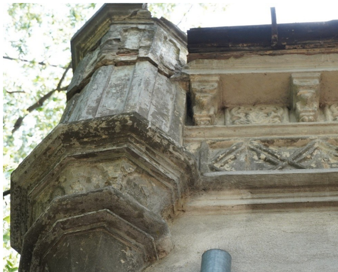
Elemente decorative cornișă, degradări datorate umidității
