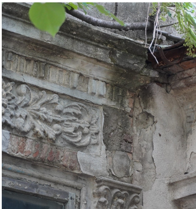
Pierderea unor elemente decorative sau a unor părți din tencuiala exterioară
